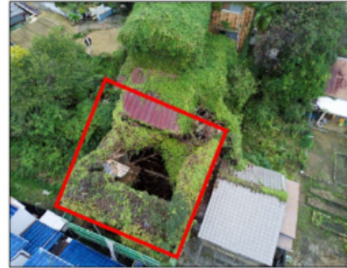
老朽化により屋根が崩落、壁だけで自立しており、倒壊等著しく保安上危険な状態
