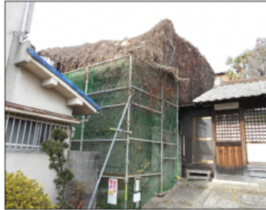
老朽化により屋根が崩落、壁だけで自立しており、倒壊等著しく保安上危険な状態
