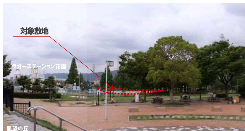
写真-1 緑化活動拠点施設 対象敷地 (遠景)
