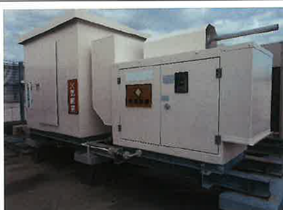
空調機制御盤全面塗装
