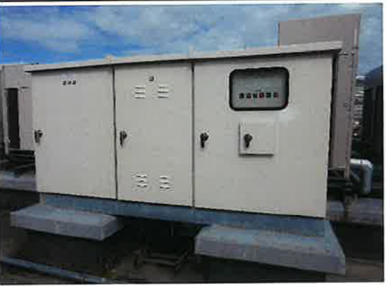
空調機制御盤全面塗装
