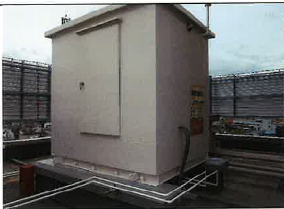
非常用発電機油庫全面塗装
