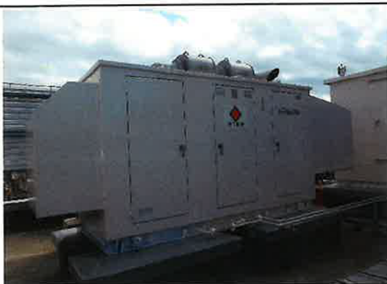
非常用発電機全面塗装
