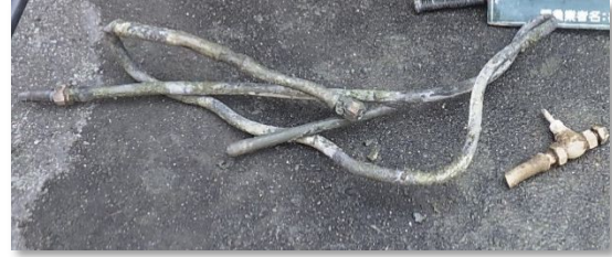
撤去後の鉛製給水管
