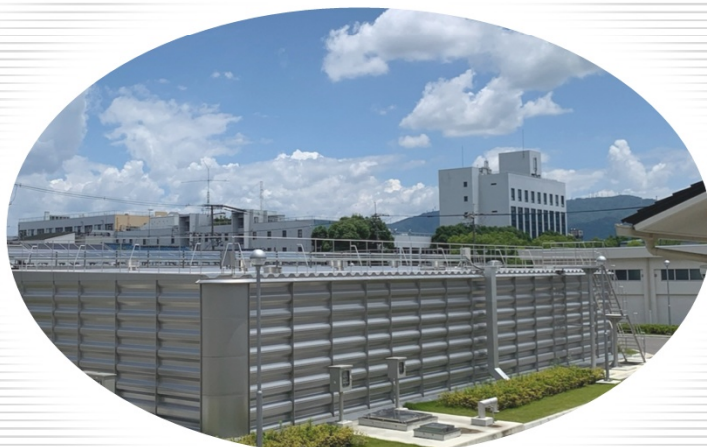
上小阪配水場 ステンレス鋼板製配水池
