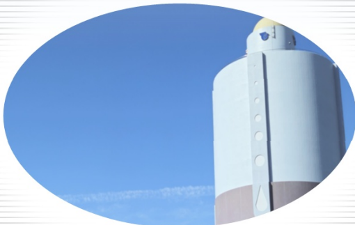
池島配水場 上部配水池
