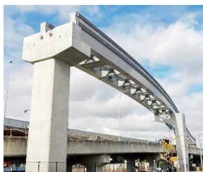
モノレール建設事務所の鋼軌道桁建設工事の様子
