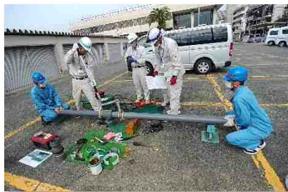
水道管接合実技研修の様子
