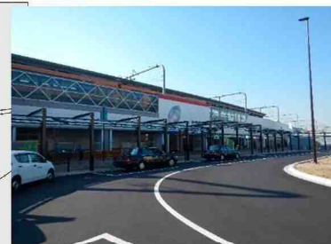
◆整備例（東花園駅前交通広場）
