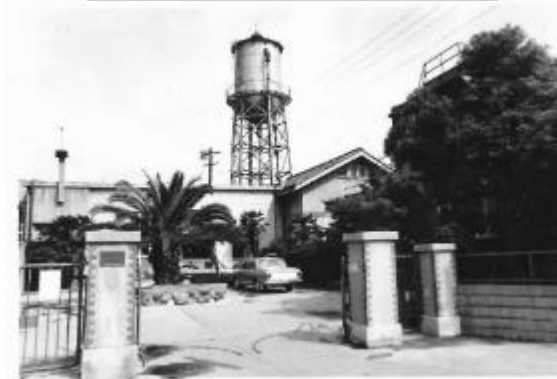
菱屋西配水場(創設当時)
