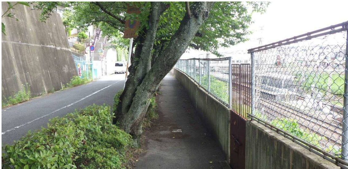
歩道幅員が狭く、街路樹が大径木に成長しているため 通行支障が発生している
