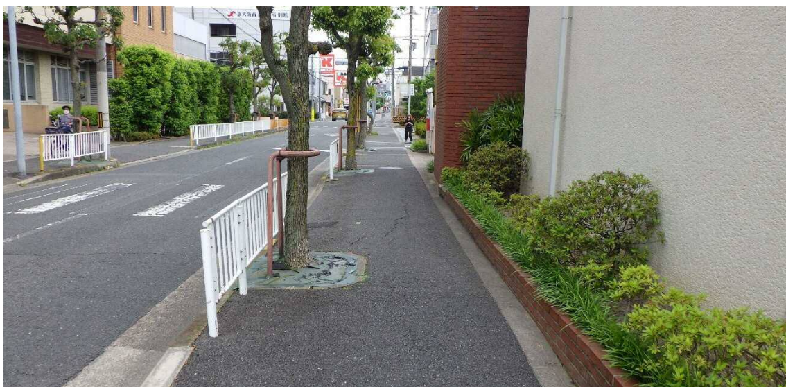
歩道幅員が狭い路線に植樹しているため、 適切な有効幅員が確保できていない
