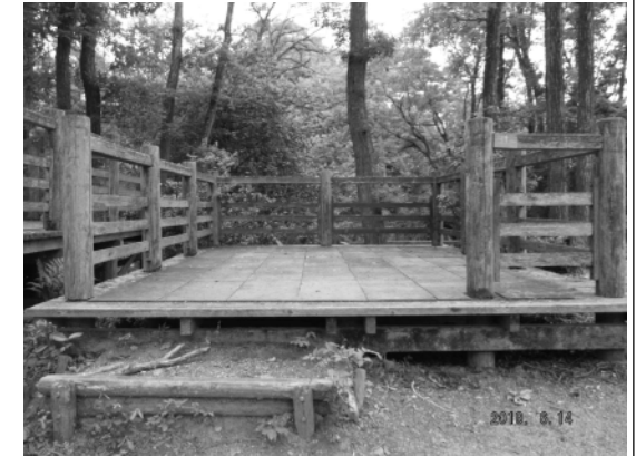
No11. 12現況写真
