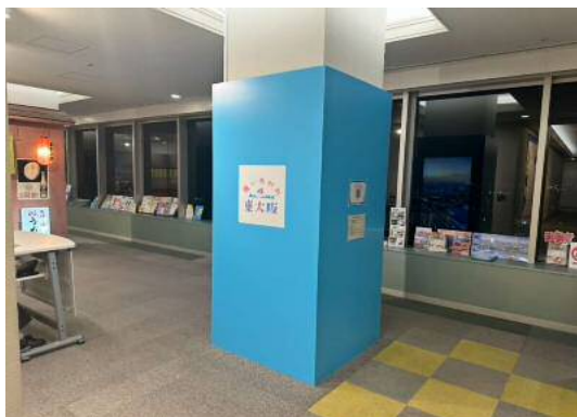
①柱巻き石膏ボード（4箇所）
