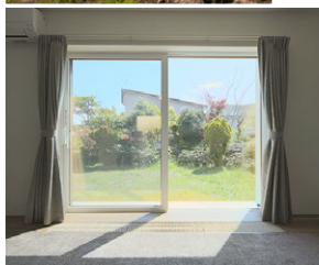
外窓交換（はつり工法）を実施
