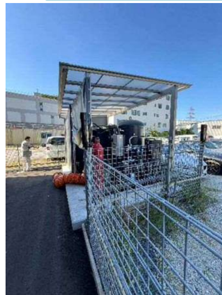
※防音壁設置の様子
