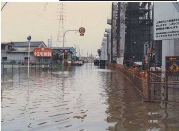
国道308号 (昭和59年)
