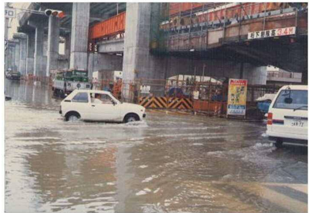
国道308号 (昭和59年)
