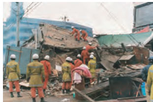
阪神・淡路大震災で被災した建物
