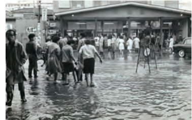
浸水被害が発生した昭和38年ごろの近鉄布旗駅前
