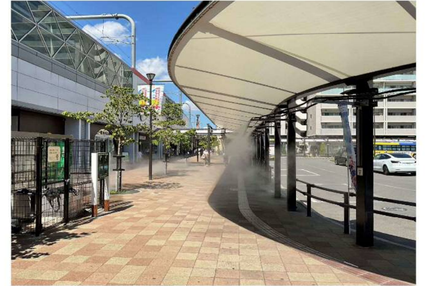
ツリー+No.1+柱+No.2 稼働稼働
