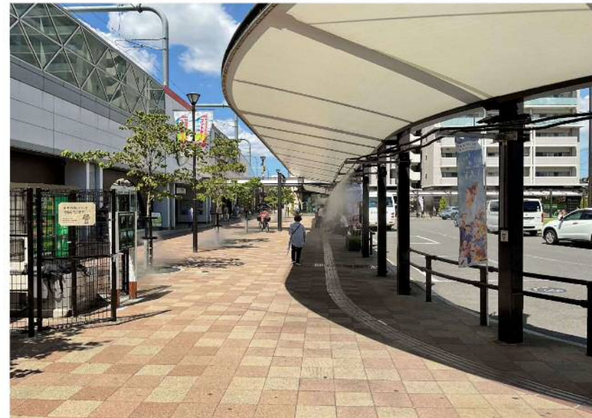
ツリー+No.1+柱 稼働
