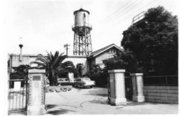
菱屋西配水場(創設当時)
