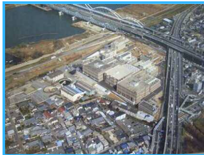
大阪広域水道企業団 庭窪浄水場
