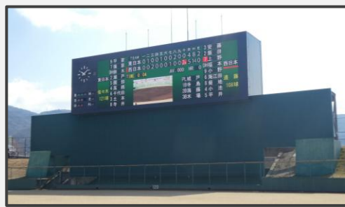
スコアボード改修
