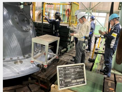
工場立会検査でポンプの試運転を行う
