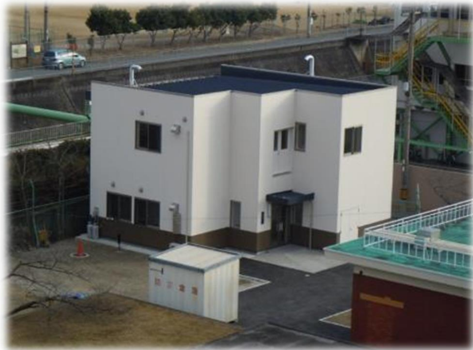
水質試験棟（水走配水場内）
