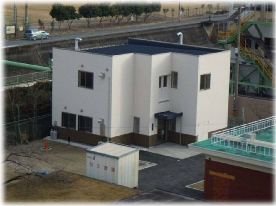
水走配水場内に構える水質試験棟
