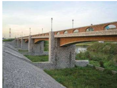
恩智川治水緑地
