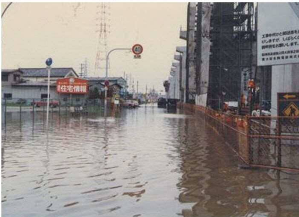
国道308号 (昭和59年)
