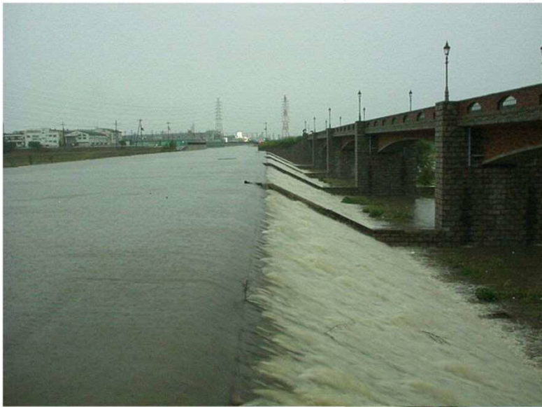
池島 I 期越流状況
