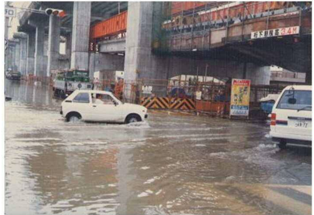
国道308号 (昭和59年)
