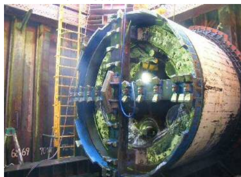
地中を掘削するマシン
