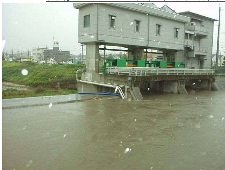
花園多目的遊水地越流堰 (越流直前状況)
