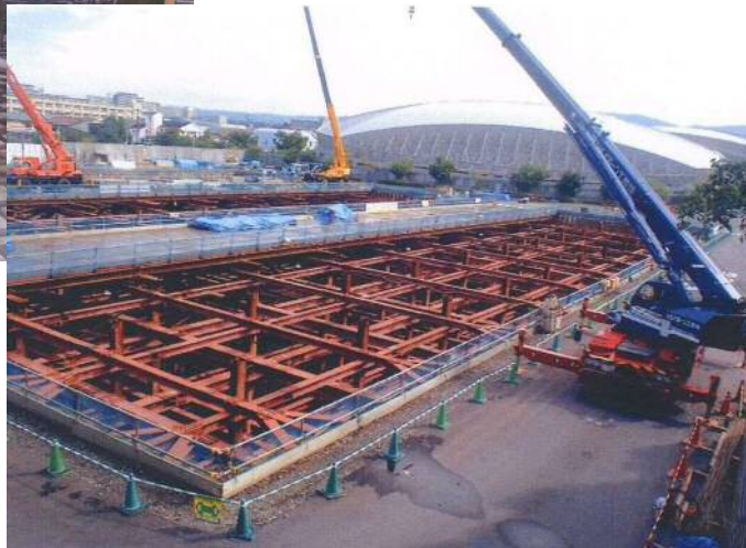
八戸の里公園（小阪）調節池 施工状況（上面）
