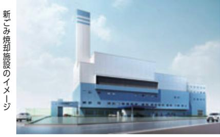
【新施設の概要】 水走4-6-25 東大阪都市清掃施設組合敷地内 施設の種類 ごみ焼却施設(焼却能力は238t/日(119t/日x2炉))
