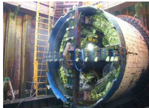
地中を掘削するマシン
