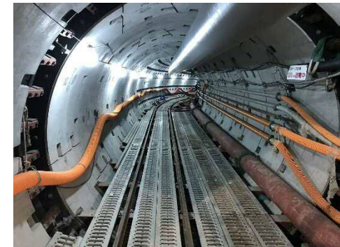
増補管 施行中
