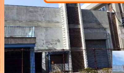
工事前の様子
