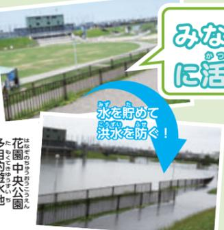
大雨などで川の水が急に増えたとき、その一部を「遊水地」に貯めて川の水の量を少なくする方法があります。花園中央公園の多目的遊水地は、普段は遊べる場になっていますが、災害時には川の水を流し、洪水が起らないようにこの「遊水地」として活用されています。
