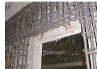
下水処理場の耐震化
