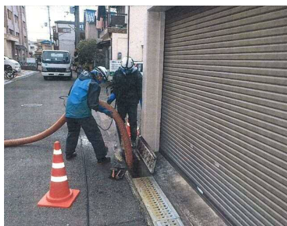
写真：ます清掃の様子
