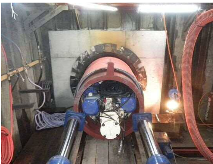
写真：バイパス管の施工状況
