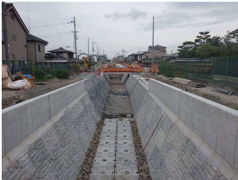
写真：改修工事の施工状況
