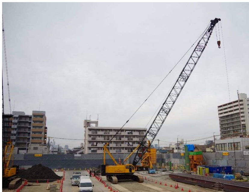
写真：布施公園（高井田）調節池の施工状況
