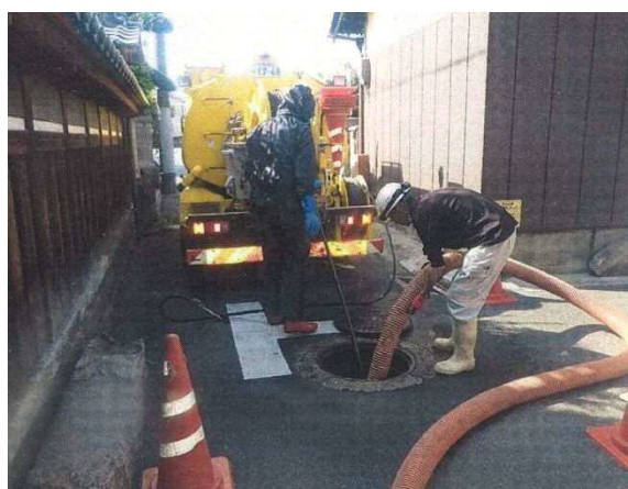
写真：管路清掃の様子
