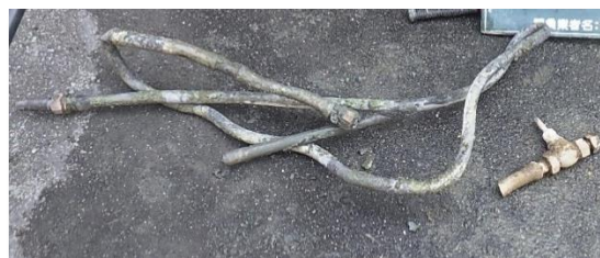
撤去後の鉛製給水管
