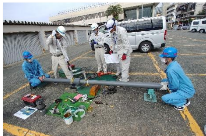
水道管接合実技研修の様子
