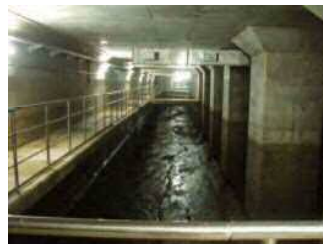
▲宝町雨水貯留施設
