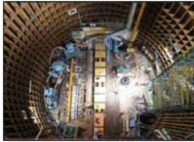
▲立坑(上空写真)
