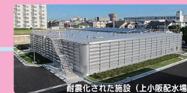
耐震化された施設（上小阪配水場）
