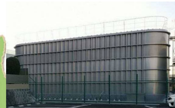
五条低区配水池
