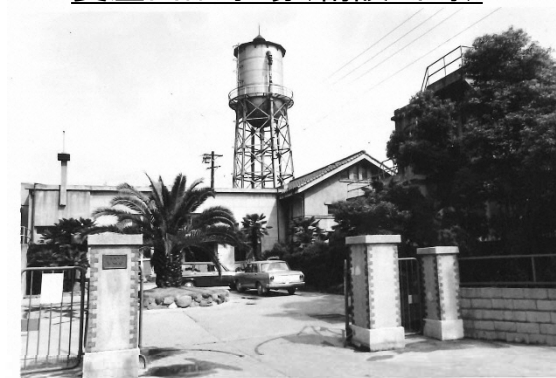
菱屋西配水場(創設当時)
