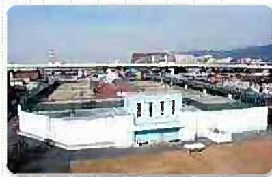
●水走配水場ルーフェニスコート(4号配水池上部)
