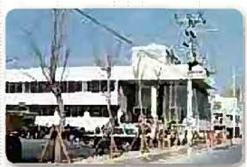
●水道庁舎完成当時
