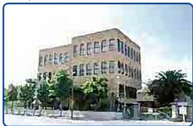
菱屋西配水場
