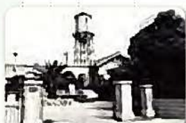
●昭和42年菱屋西浄水場
