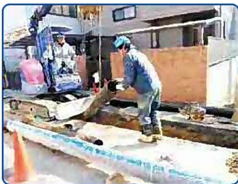
管路の更新工事
