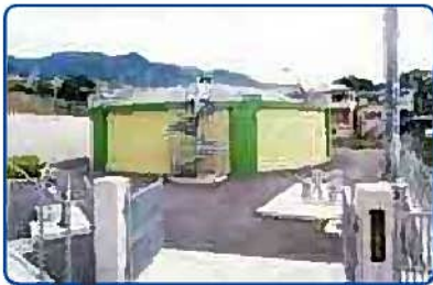
石切低区浄水場
