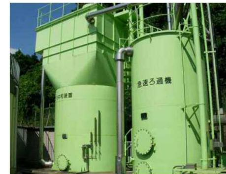
凝集沈殿装置、急速ろ過機
