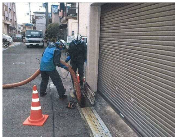
写真：ます清掃の様子
