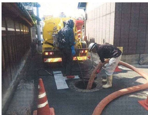
写真：管路清掃の様子
