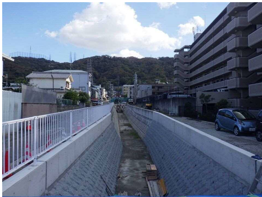
写真：改修工事の施工状況
