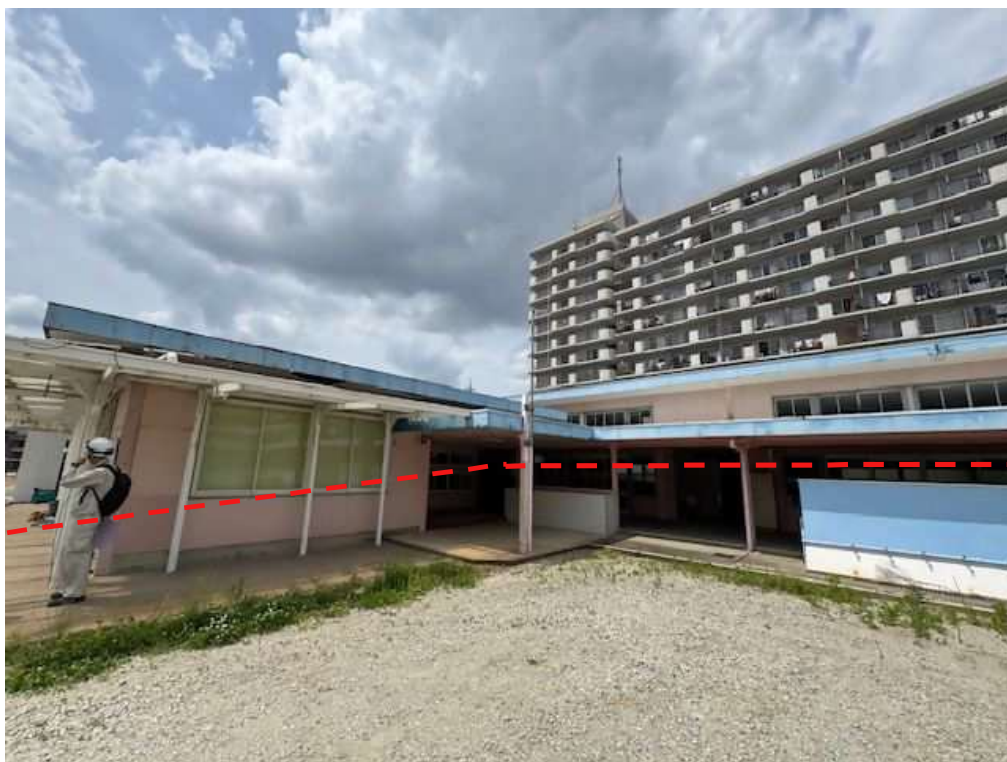
①北東から南西を撮影
