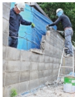
7月3日には成和小学校のブロック塀の撤去を開始しました
