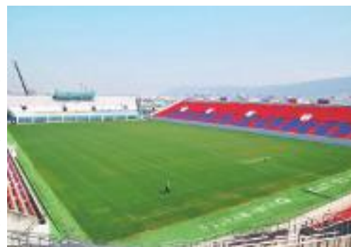
改修工事中の市花園ラグビー場のグラウンド（3月現在）
