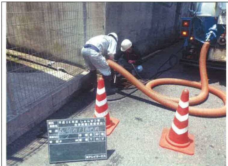
写真：ます清掃の様子
