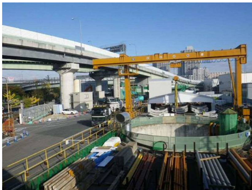
写真：中央北増補幹線の施工現場
