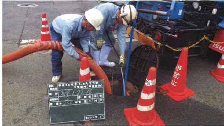
写真：管路清掃の様子
