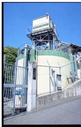
上石切町特別高区CE配水池
