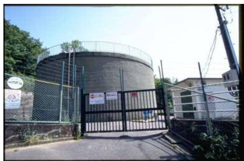
上四条高区配水池
