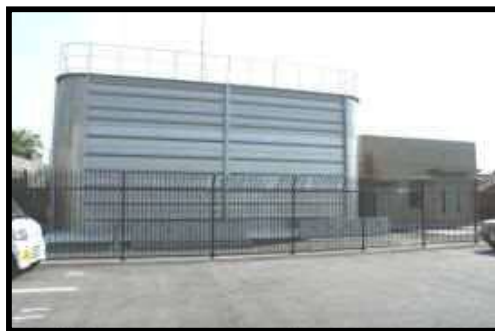
六万寺配水池
