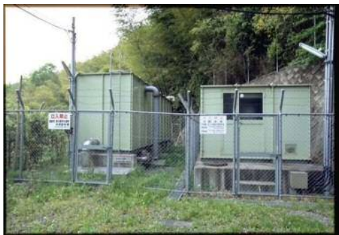
上石切町特別高区A配水池
