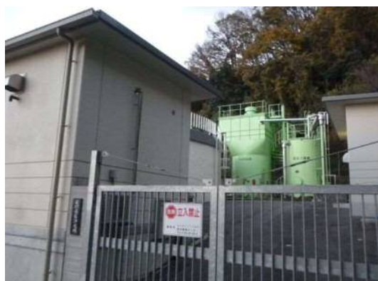
石切高区浄水場
