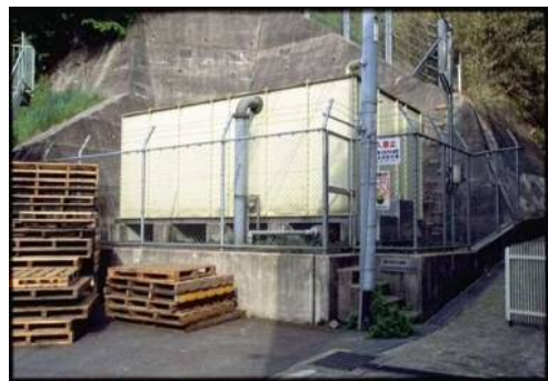
上石切町特別高区B配水池
