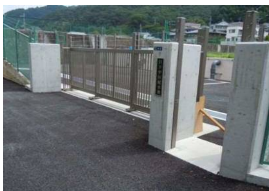
日下中区配水池
