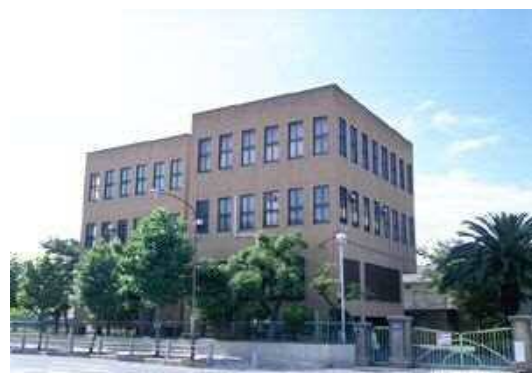
菱屋西配水場
