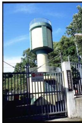
山手町特別高区BC配水池
