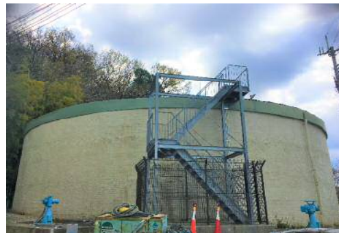
五条中区配水池
