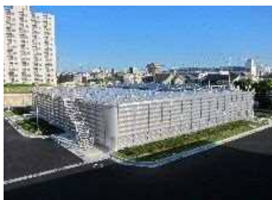
上小阪配水場
