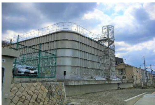
五条低区配水池
