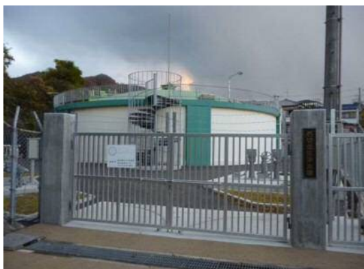
石切低区浄水場
