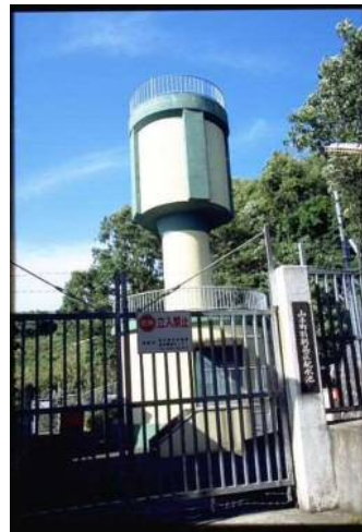
山手町特別高区BC配水池
