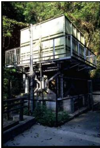
山手町特別高区A配水池
