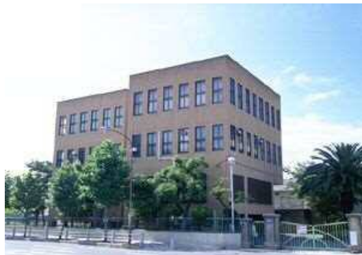
菱屋西配水場
