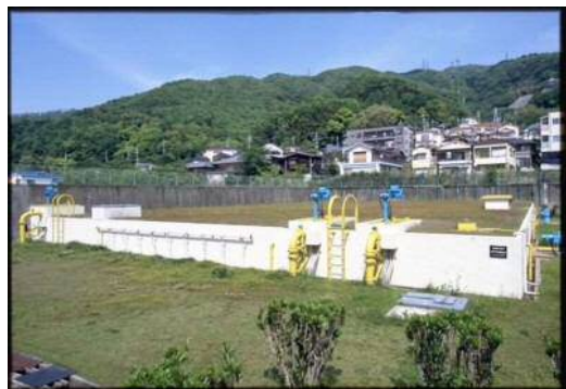
日下中区配水池
