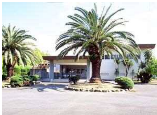
上小阪配水場
