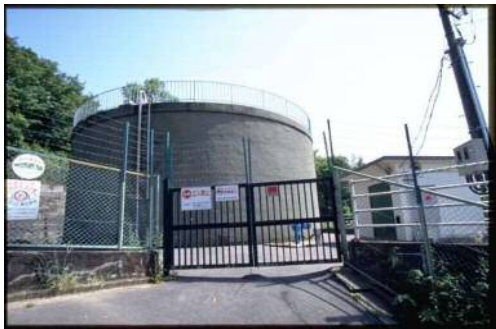
上四条高区配水池
