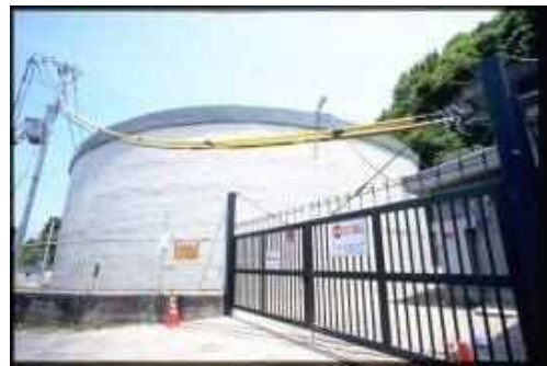
五条中区配水池
