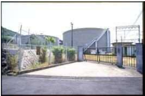
五条低区配水池
