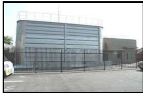
六万寺配水池
