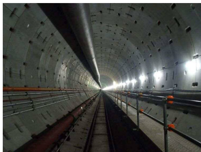
（写真：新大蓮幹線（増補管））
