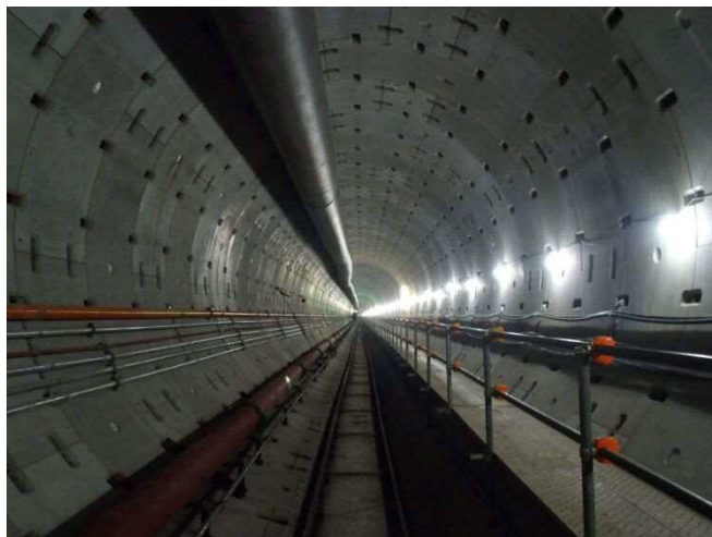
（写真：新大蓮幹線（増補管））
