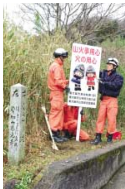
山林内に防火標識を設置
