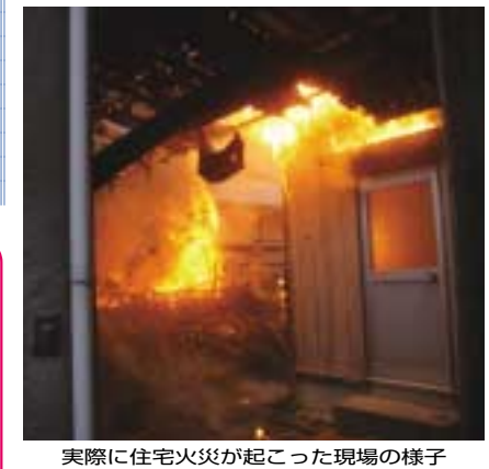
実際に住宅火災が起こった現場の様子
