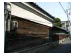
剣先舟の廃材を再利用した民家の壁(中小阪の旧集落)
