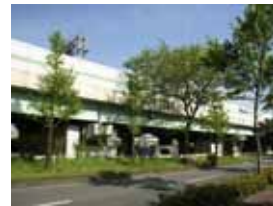
近畿自動車道の高架構造物
