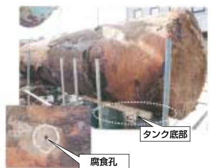
地下に埋設され腐食・劣化した貯蔵タンク ※「地下埋設危険物施設からの流出事故防止対策」(財団法人危険物安全協会発行)から転載
