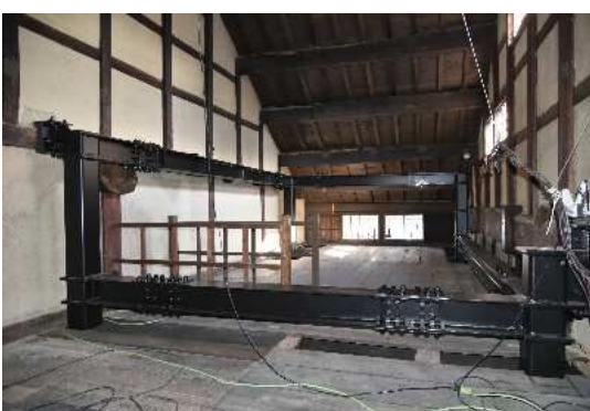
⑦ 本屋二階耐震補強状況
