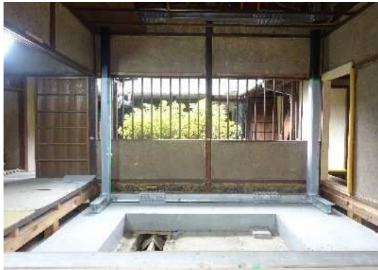
⑥ コンクリート打設完了
