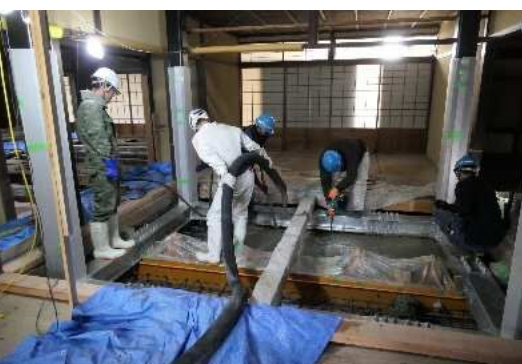
④ コンクリート打設
