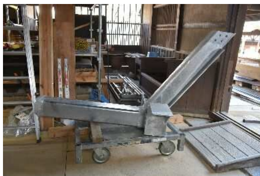
① 補強鉄骨(北面下屋)
