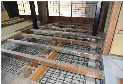
③ はいきん 配筋状況
