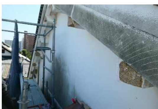
⑪ こめぐらつくいほしゅう 米蔵漆喰補修施工中
