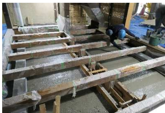
⑤ コンクリート打設状況
