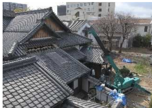
② 鉄骨搬入(北面下屋)
