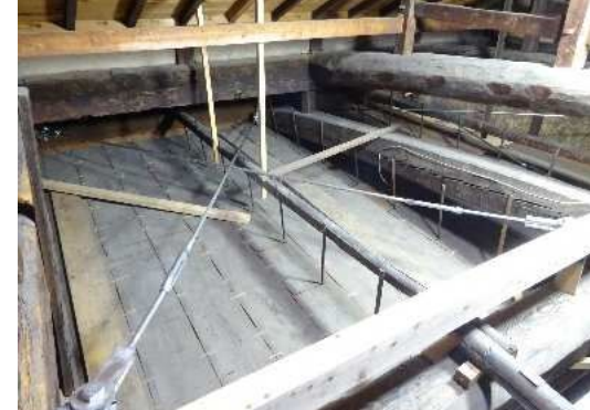
⑧ 小屋裏耐震補強状況
