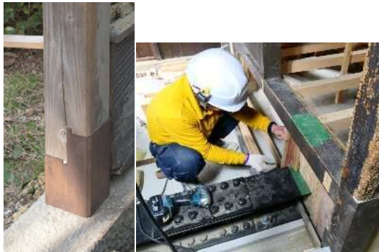
⑨ 木部補修状況
