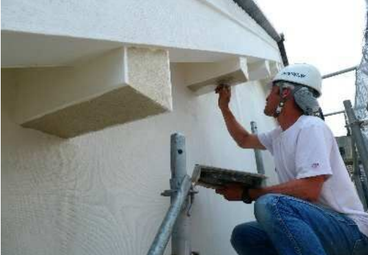
⑫ こめぐらつくいぬり 米蔵漆喰塗補修状況
